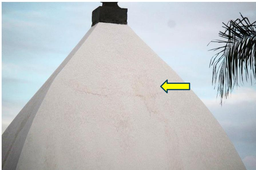
Imagem: Obra de conservação das Capelas dos Passos, após um mês de nova pintura, já apresentava acúmulo de poeira – 28/05/2024
