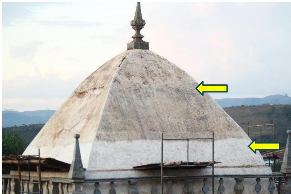
Imagem: Obra de conservação das Capelas dos Passos, remoção das sujidades da cúpula mostrando o contraste da pintura – 10/04/2024
