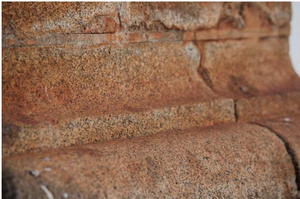
Imagem: Detalhe dos granitos da fachada frontal da Basílica com tonalidade amarelada pelo acúmulo de poeira – 27/05/2024
